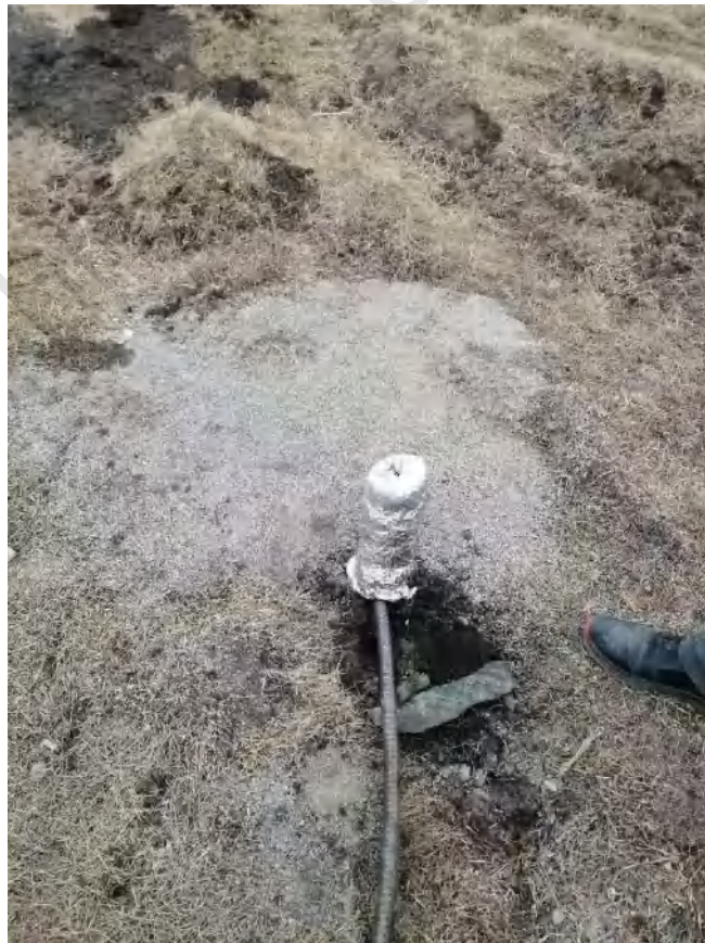
图 2 深孔温度链安装完成图
